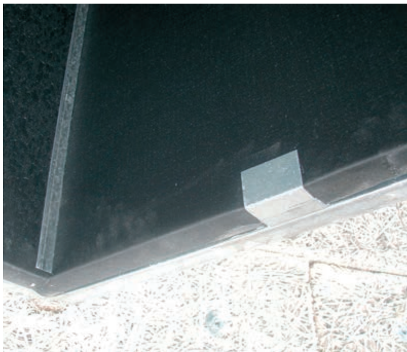
Patte d'arrêt soudée au conduit.
