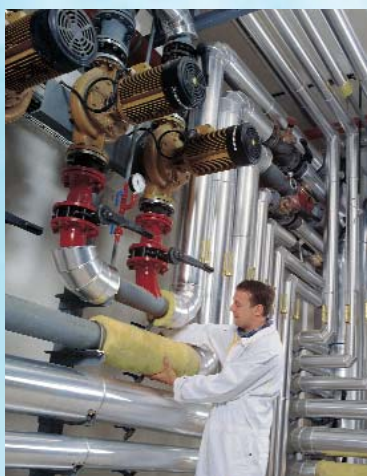
Coquille PROTECT 1000 S en chaufferie.
