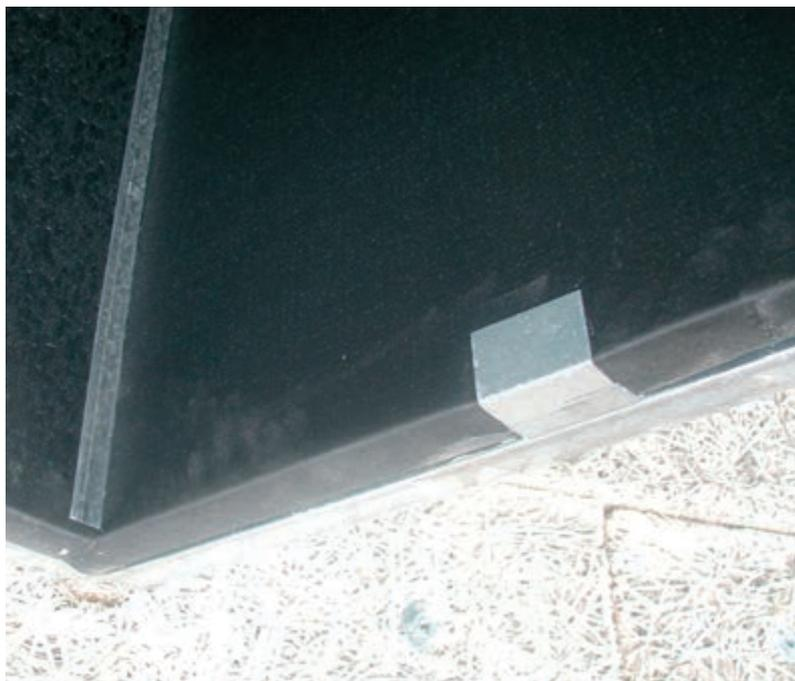
Patte d'arrêt soudée au conduit.
