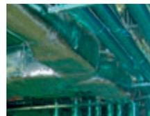
Les solutions ISOVER pour l'isolation des conduits de ventilation en métal, placées à l'extérieur de la gaine. CLIMCOVER est la solution parfaite pour apporter isolation thermique et permet d'éviter les phénomènes de condensation des conduits en métal.
