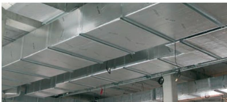
gaines CLIMAVER 284 et A2 Plus et A2 DECO Noir, la surface des panneaux étant directement en contact avec les bruits véhiculés par l'air.
