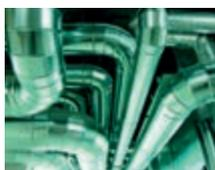
Les coquilles ISOVER pour l'isolation des conduits d'eau. Les coquilles PIPE SECTION ALU2 apportent des hauts niveaux d'efficacité pour l'isolation thermique et empêchent la condensation.
